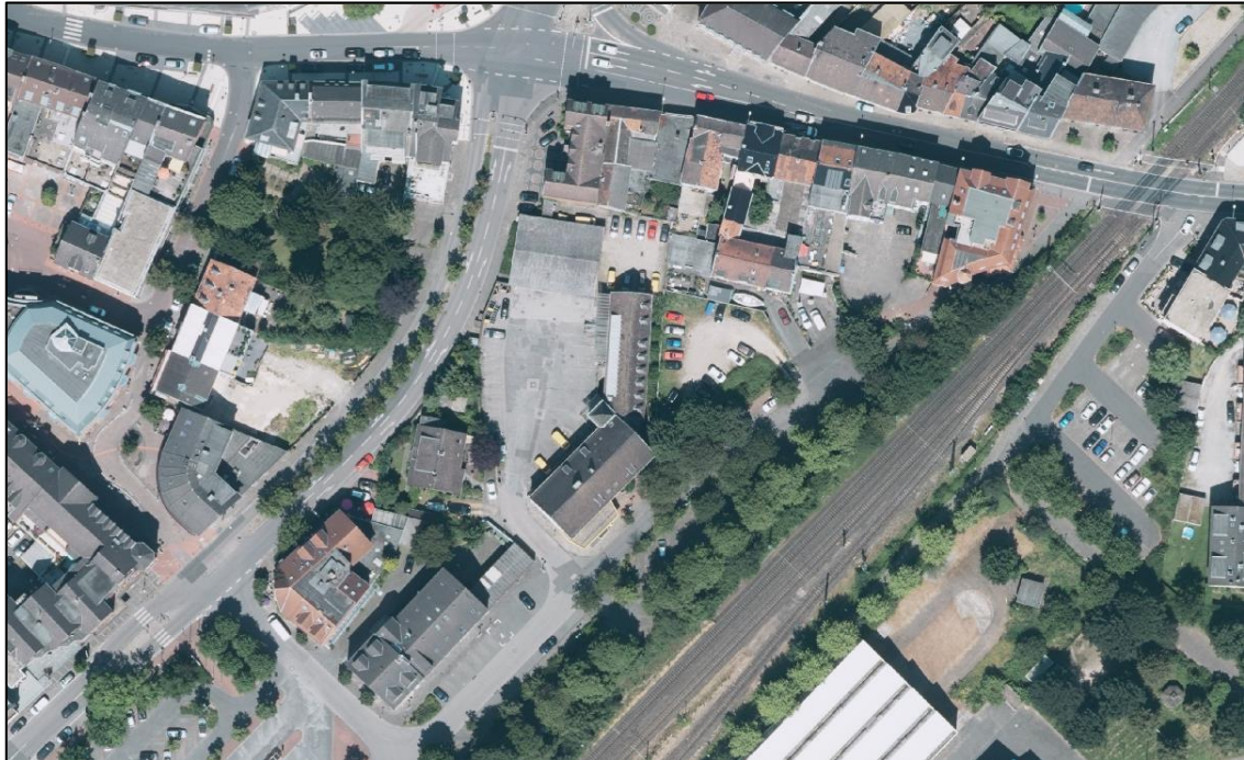
Abbildung 2: Unmittelbares Plangebiet und Umgebung, Luftbild, Quelle: © Land NRW
