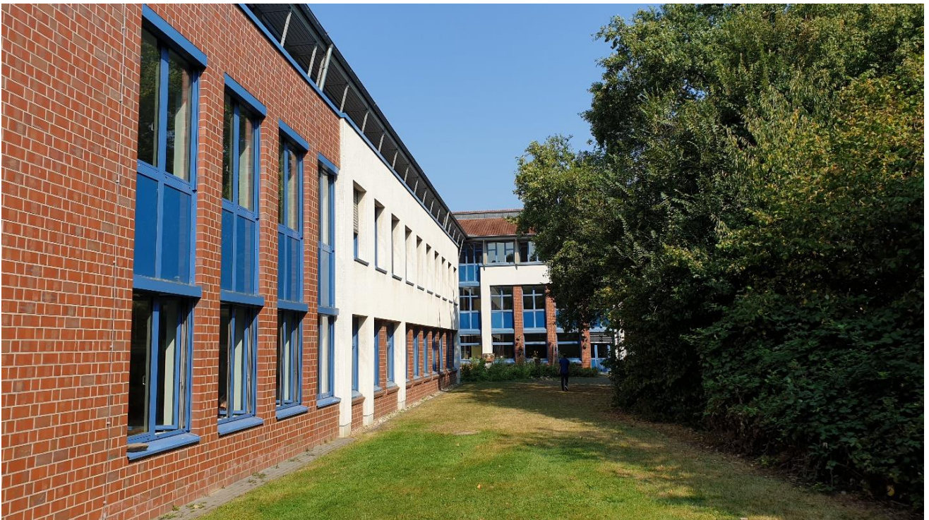
Abb. 11 Erweiterung 1991 (Putz-Ziegelfassade) und Ergänzung 2010 (Ziegelfassade)
