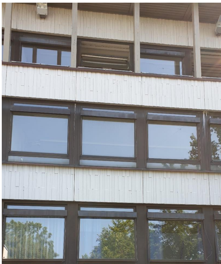
Abb. 09 Ursprünglicher Sichtbeton mit Relief und original Fensterbänder aus eloxierten Aluminiumfenstern (mit tw. erneuerten Gläsern)
