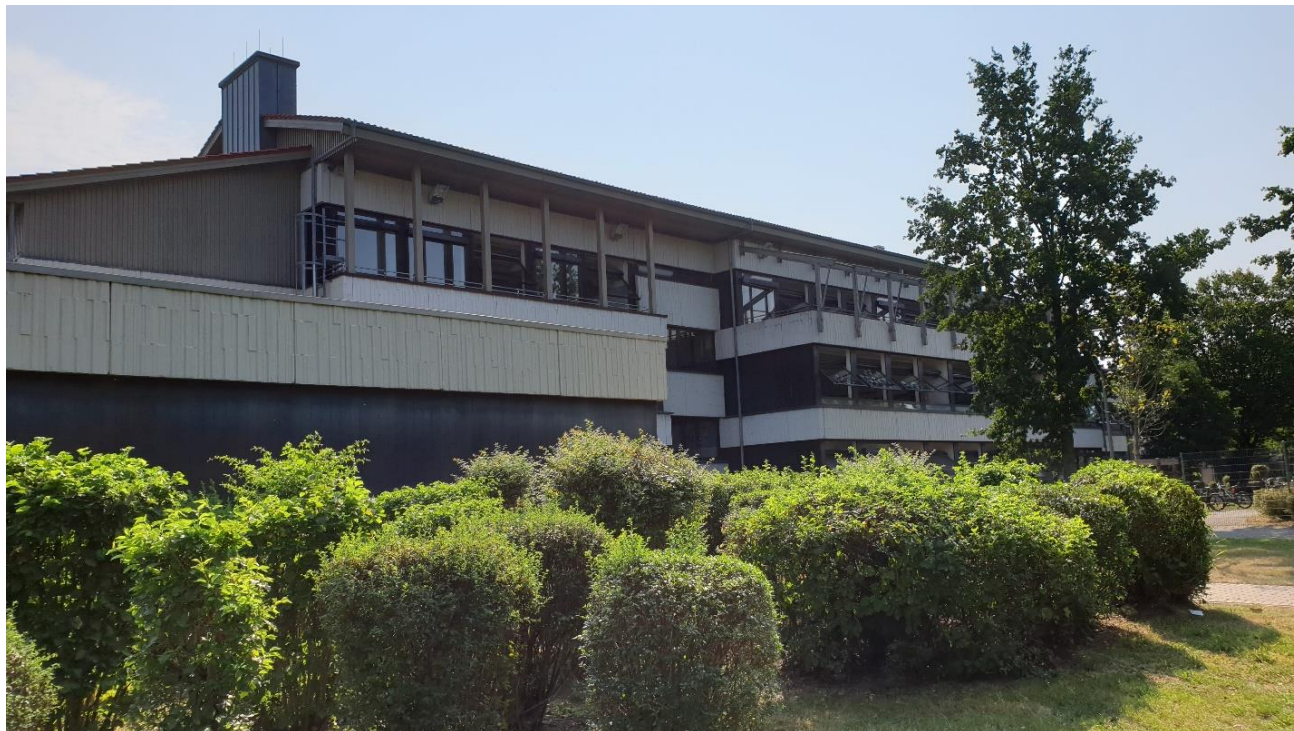
Abb. 08 Ursprünglicher Baukörper mit Betonfassade, Fensterbändern und der Satteldachergänzung
