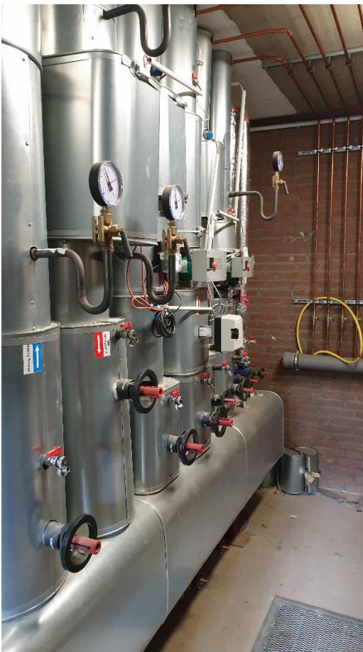
Abb. 02 Heizkreis Hauptverteilung
