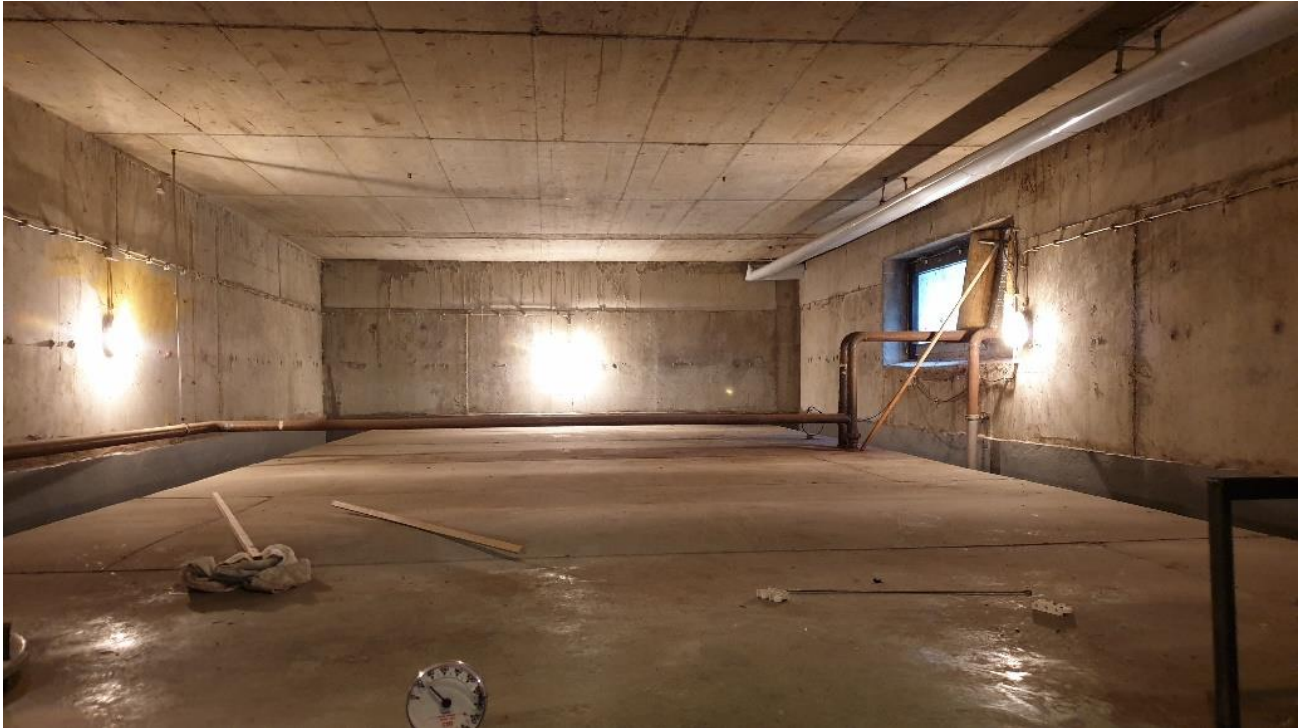
Abb. 07 Öltank 1 mit Außenfenster
