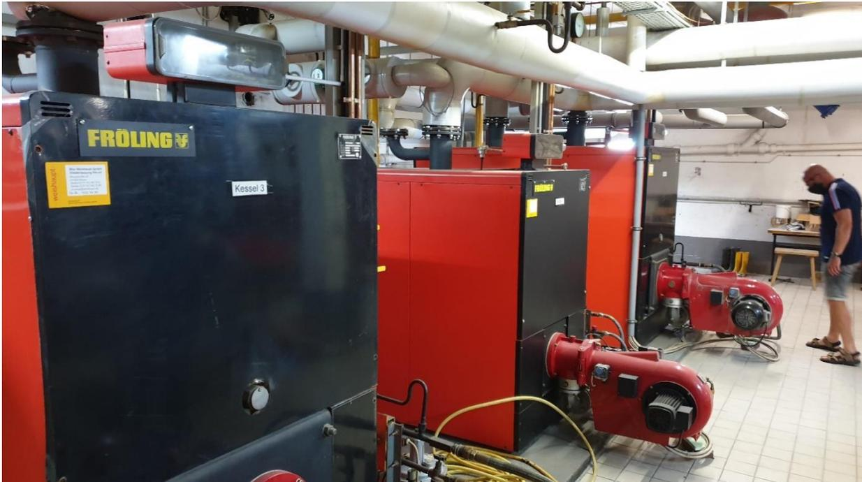
Abb. 01 Heizkessel mit Zweistoffbrenner (Öl und Gas)
